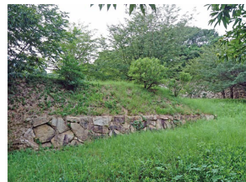
B: 二の丸は両脇に虎口を設ける。城壁は石垣と土塁で構成されている。
