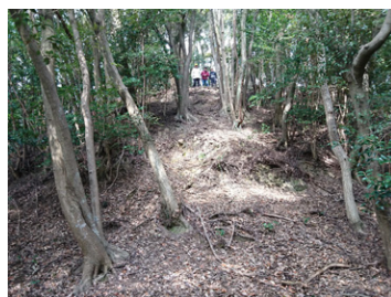
D：主郭南側の谷から見た切岸。搦手方面となるが、弱点を補う防御も堅い。
