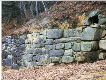
A：鬼ノ城の石積の上に土を重ねた城壘。整った割石・切石を水平に積み上げる。一部には水抜（水門）も設けられている。
