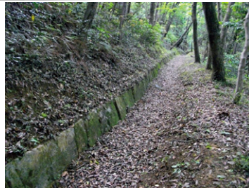
C：石城山の直線的な城壘。基礎に均一な切石を並べ、上に砂と土を交互に積み重ねた「版築」工法による土塁を築く。
