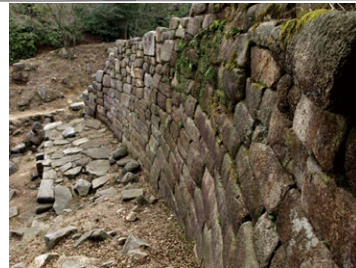
B：御所ヶ谷の谷を遮る大規模な石塁。崩落を防ぐために湾曲させ強度を保つ高度な造り。
